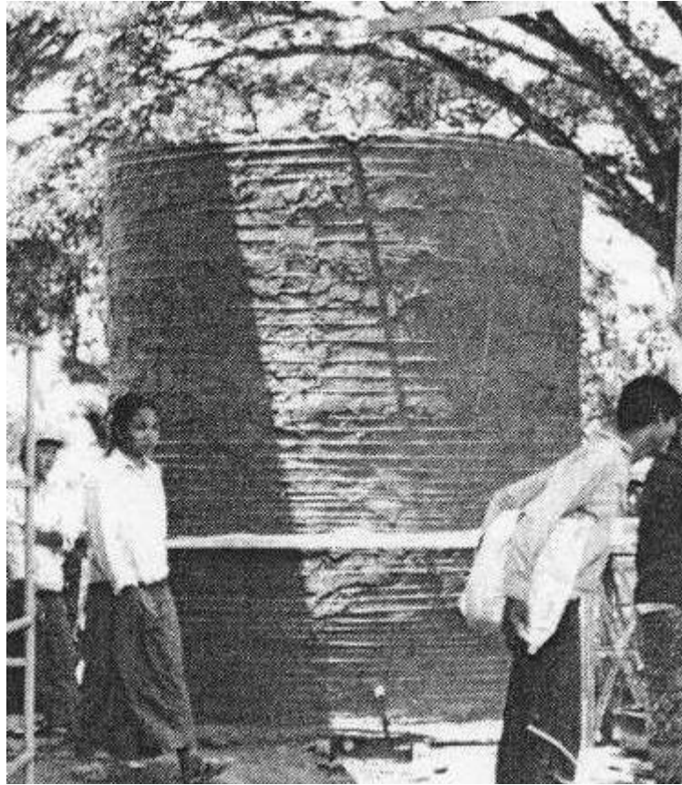
Figura 6. Cisterna de cemento-tabique
