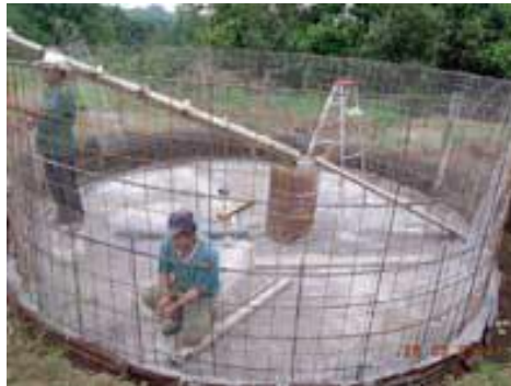
Figura 5. Construcción de tanque de ferrocemento
