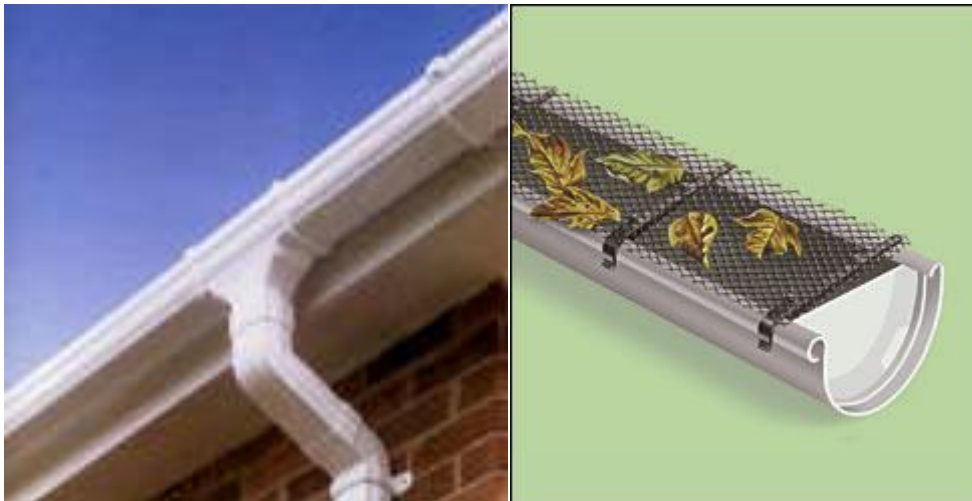
Figura 4. Canaleta de recolección y ejemplo de rejilla
